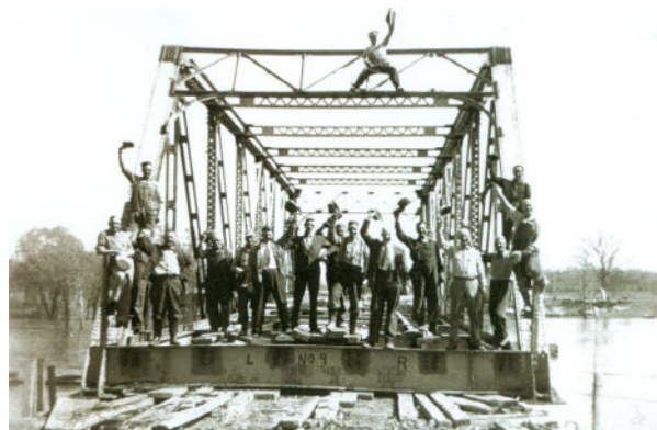
Construction du pont de l'île Goyer durant les années 1950.
