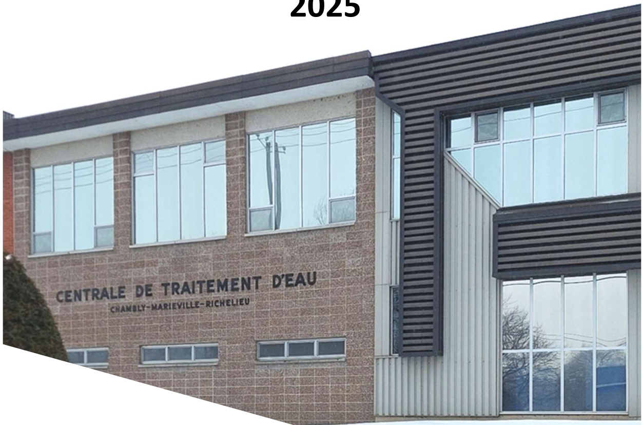
Centrale de traitement d'eau Chambly-Marieville-Richelieu, Chemin Ste-Thérèse, Carignan
