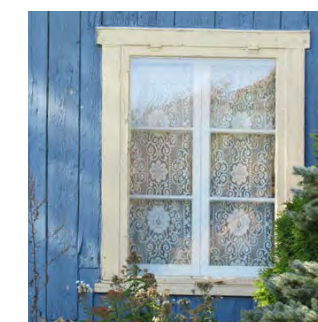
Fenêtres avec moulures
