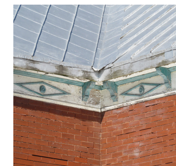
Corniche à consoles
