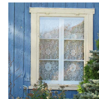
Fenêtres avec moulures
