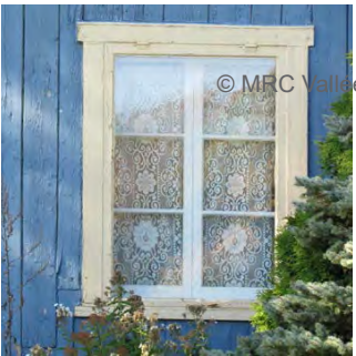
Fenêtres avec moulures
