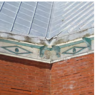
Corniche à consoles
