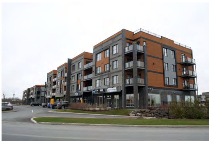
FIGURE 64 - Carignan-Salières, immeuble mixte
