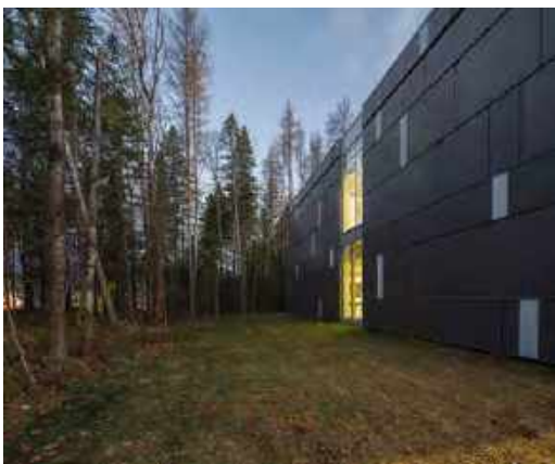
FIGURE 103 - Intégration d'une école milieu boisé, Stoneham, Québec ©CCM2 architectes
